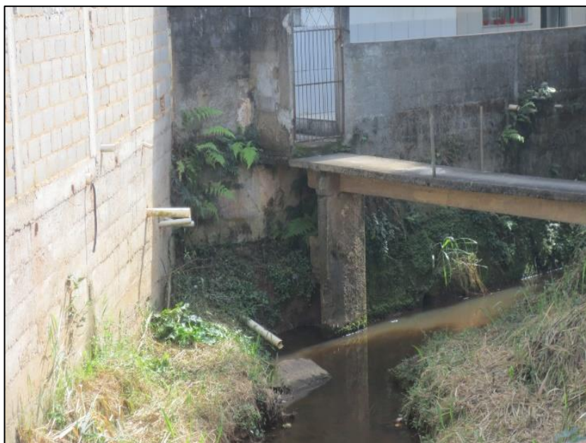
Figura 40 - Disposição de esgotos domésticos diretamente no rio.
