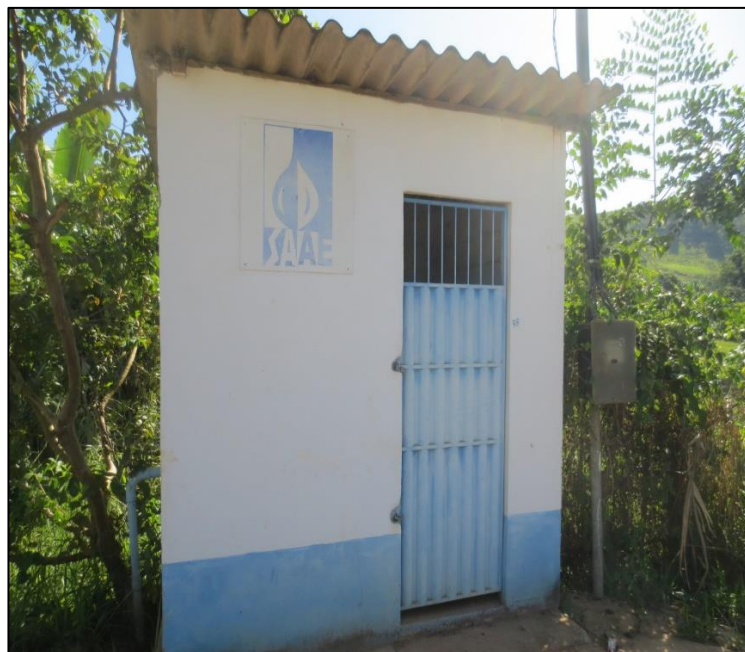
Figura 36 - Estação elevatória de água tratada.
