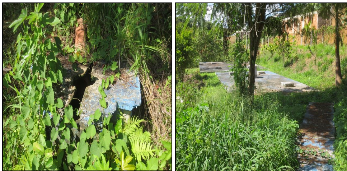
Figura 41 - ETE do Distrito Sede.
