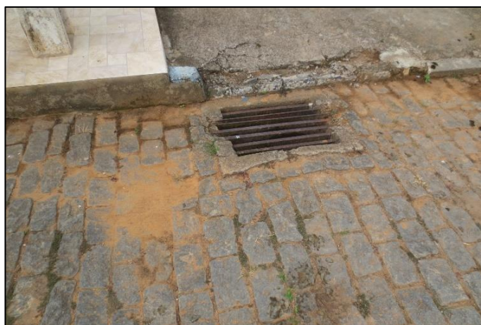
Figura 75 - Dispositivo de drenagem em Recreio.
