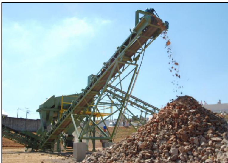
Figura 113 – Usina fixa de RCC.
