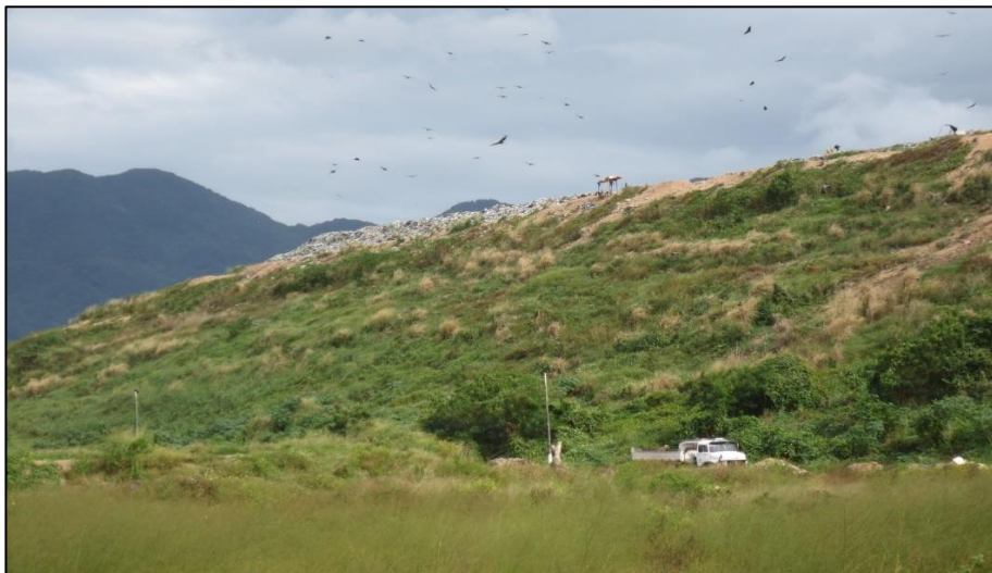
Figura 63 - Exemplo de aterro controlado.
