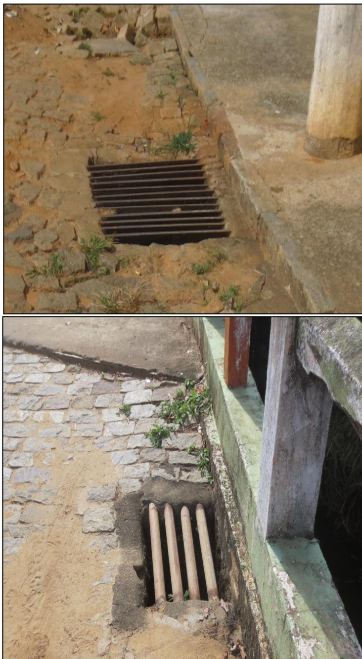
Figura 66 – Dispositivos de microdrenagem em Recreio.
