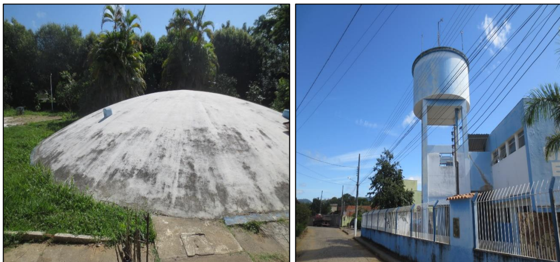
Figura 37 - Reservatórios de concreto do tipo enterrado e elevado no Distrito Sede.
