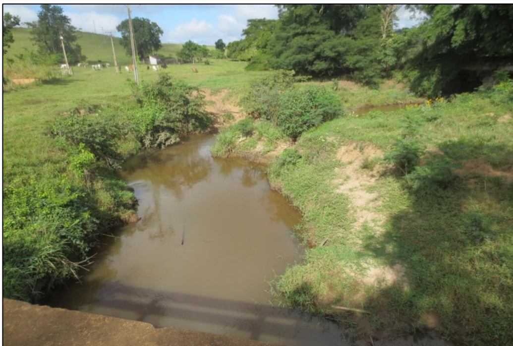
Figura 44 - Corpo hídrico receptor e lançamento de esgoto in natura no Distrito de Angaturama.
