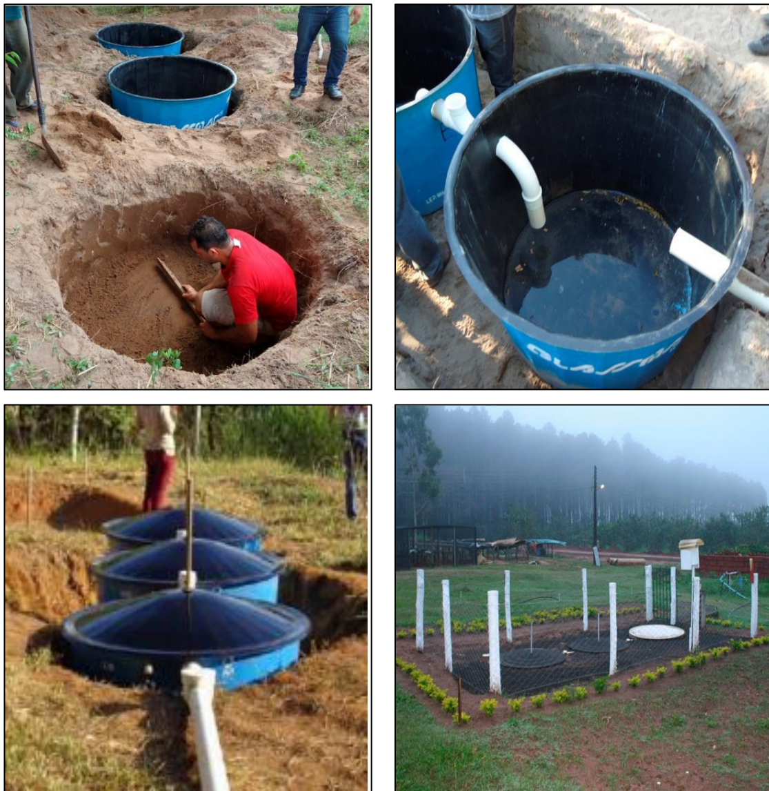
Figura 89 - Exemplo de instalação da fossa biodigestor.
