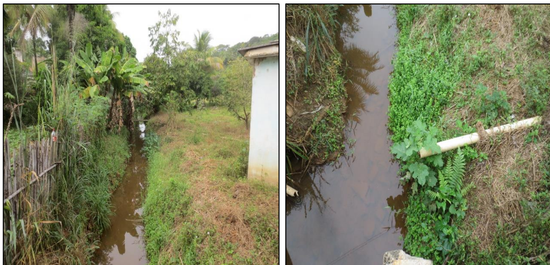
Figura 42 - Corpo hídrico receptor e lançamento de esgoto in natura no Distrito de Conceição da Boa Vista.
